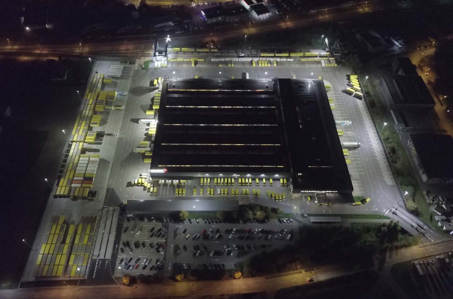
Abb.: Die Arealbeleuchtung von sechs Verteilzentren der Schweizerischen Post wurde saniert, mit neuen LED-Leuchten, einer dynamischen Steuerung und Thermalkameras ausgestattet. Im Bild ist das Paketcenter Frauenfeld zu sehen. Foto: Salvatore Cottitto
