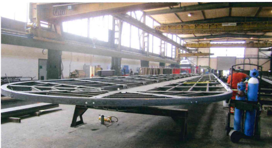
Die Stahlkonstruktion wurde zuerst in der Werkstatt des Metallbauers zusammengesetzt, sorgfältig bearbeitet und mit allen Montagepunkten versehen. Dann wurde sie wieder zerlegt und in Einzelteilen zur Baustelle transportiert und dort erneut aufgebaut.
