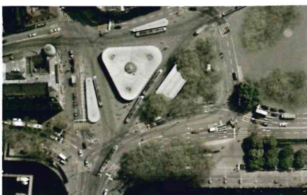
Der Verkehrsknoten Bellevue mit dem historischen zentralen Rondell und den beiden neuen Wartedächern an den Haltestellen Theaterstrasse und Rämistrasse.
