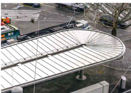
Die äusseren Kanten der Metalldeckung haben alles das gleiche Mass, auch in den Rundungen der Schmalseiten. Dadurch wirkt die Teilung sehr harmonisch.
