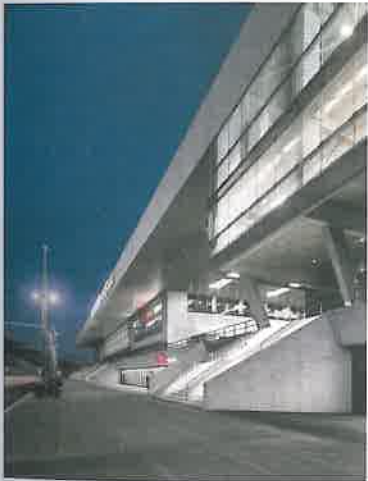
Ein einziges Dach überspannt die Stadlen.
