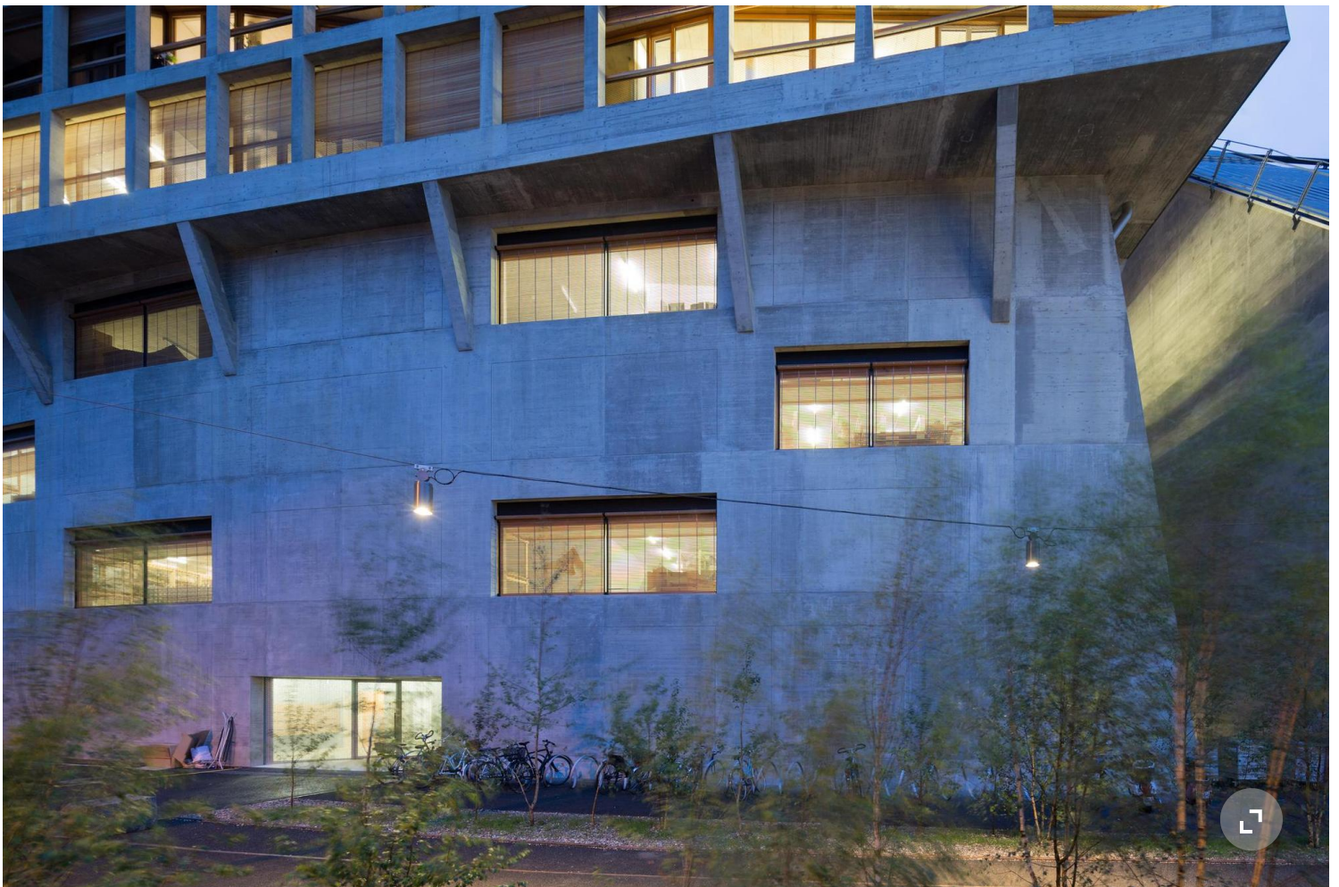
Meisterschaft in Beton: Sockel des Hauses «Helsinki Dreispitz» von Herzog & de Meuron in Basel.
