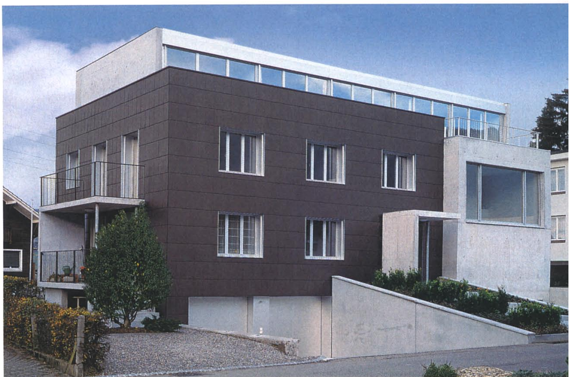
Das alte Haus hat ein neues Gesicht erhalten. (oben) Dabei blieben vier Fünftel des Altbaus (links) bestehen. Neu hinzugekommen sind die hinterlüftete Schieferfassade, das Attikageschoss und ein Anbau.
