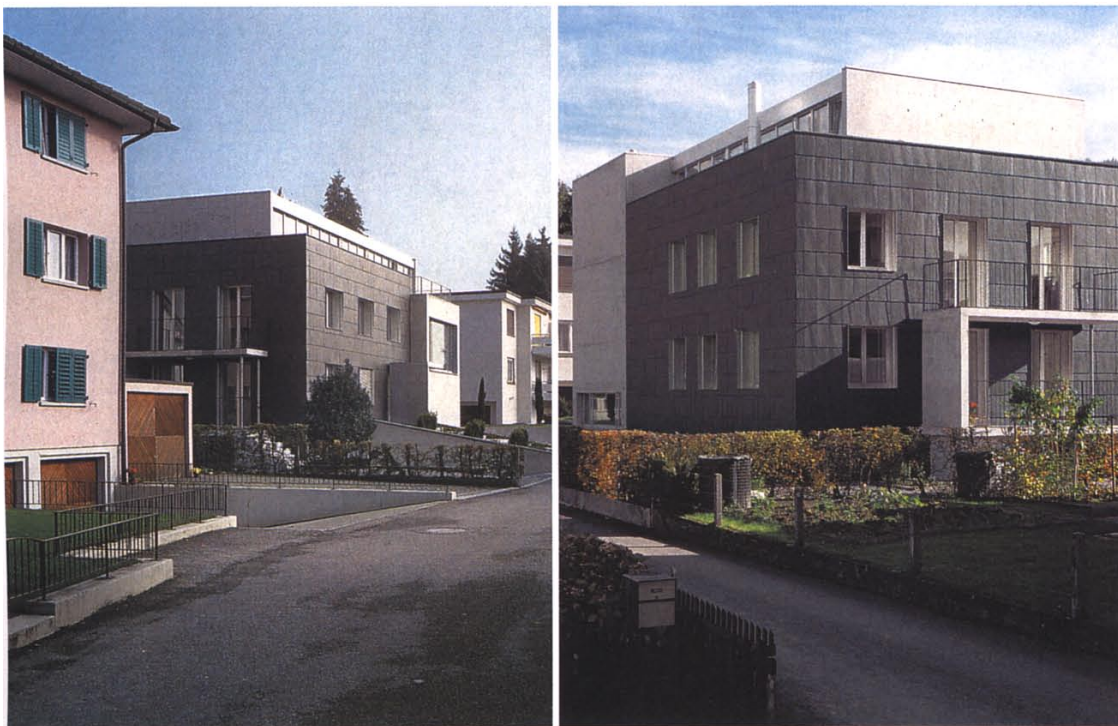
Die neuen Eingriffe «verzahnen» sich mit der alten Substanz. (links) Die Wirkung des Schiefers wechselt mit dem Licht. (rechts)
