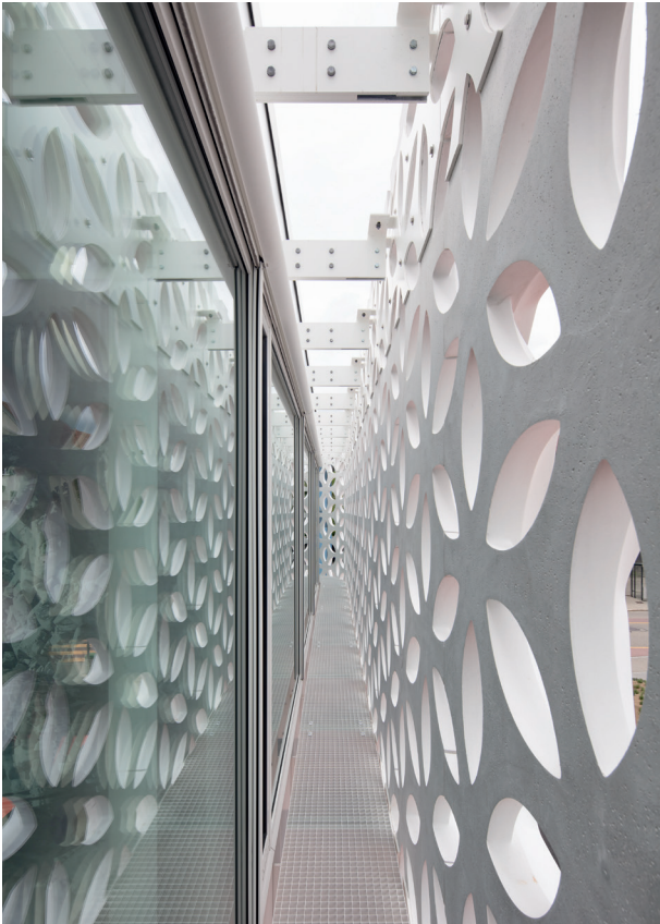
Hinter den Glasfaserbeton-Elementen befindet sich eine systemoptimierte Schüco Fassade mit hervorragender Wärmedämmung. (Bild: Faruk Pinjo)
